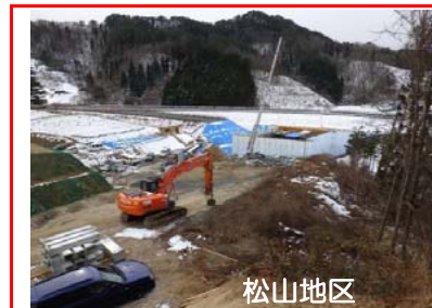
⑦施工：飛鳥建設
