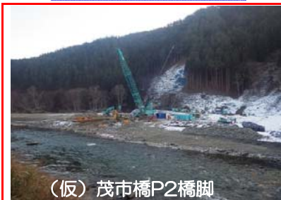
⑩施工：森本組
