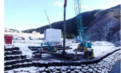
(仮)上茂市橋P1橋脚
