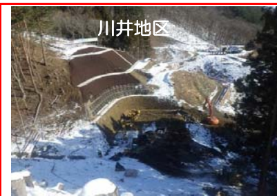
⑧施工：大豊建設
