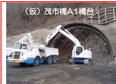
⑥施工：前田建設工業
